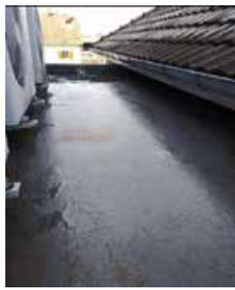
Le toit plat après travaux
