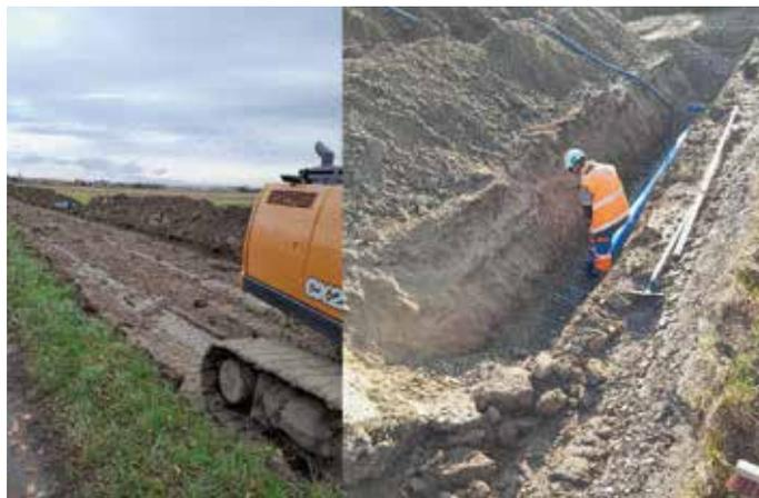
Le remblaiement de la fouille se fait à l'avancée, afin que les parcelles agricoles soient rendues aux différents exploitants agricoles.
